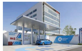
中規模 水素ステーション
